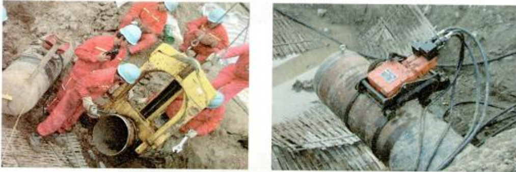
图 6-23 断管取球
