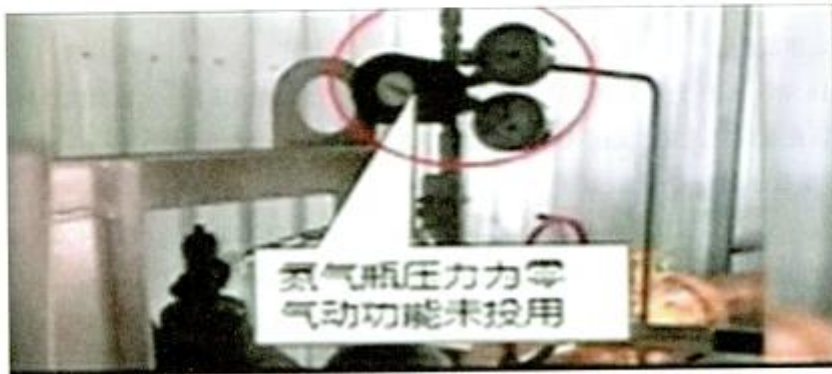
图 6-35 气液联动阀驱动装置
