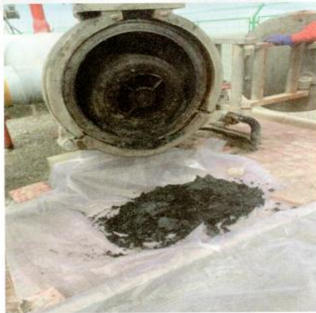
图 6-44 机械测径清管器清管情况
