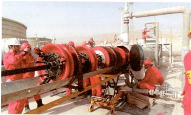
图 5.7 检测器正在发球照片
