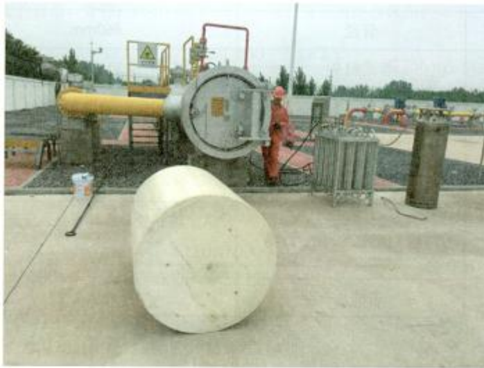
图 6-37 氮气置换
