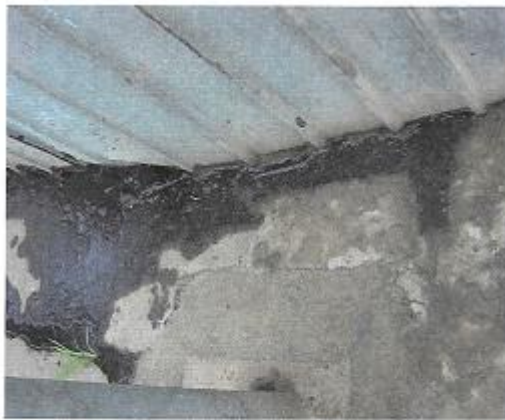
图 3.13 原油储罐底板腐蚀泄漏
